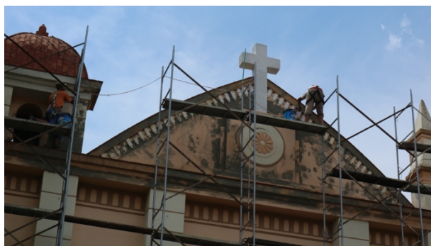
Reparos na parede da igreja / Uzupełnianie tynku
